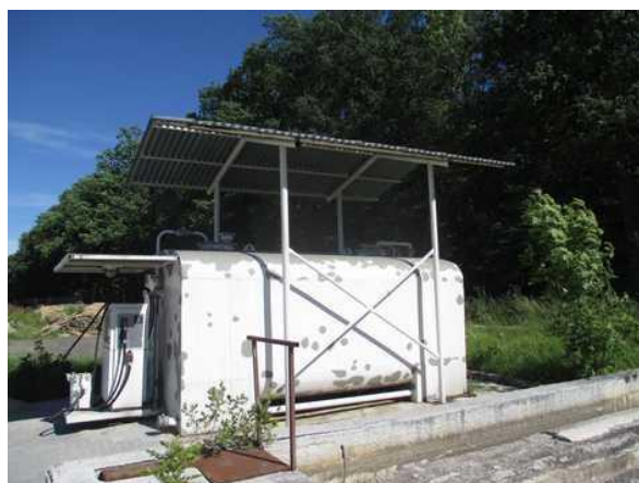
boční pohled na nádrž
